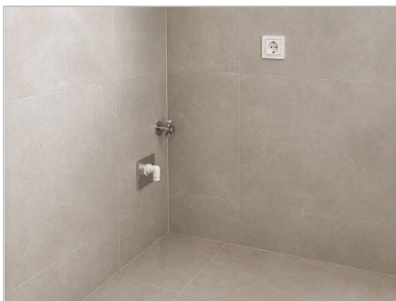
příklad provedení vývodů pro připojení pračky v koupelně
