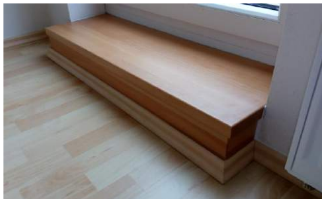
stupeň u jednokřídlových balkonových dveří
