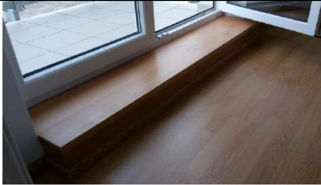
stupeň u dvoukřídlových balkonových dveří
