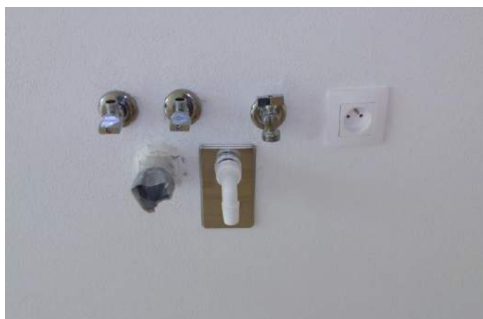
provedení vývodů za kuchyňskou linkou pro dřez a myčku – ve standardu jsou rozvody zasekané pod omítku s výjimkou bytu č.3 kde jsou rozvody vedeny na omítce
