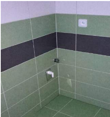
příklad provedení vývodů pro připojení pračky v koupelně
