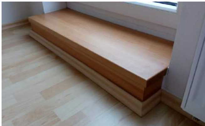
stupeň u jednokřídlových balkonových dveří
