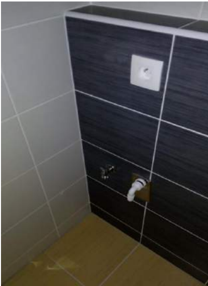
příklad provedení vývodů pro připojení pračky v koupelně
